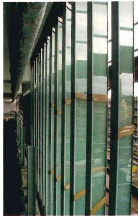
Bild 1. Links: Schäden infolge zu großer Durchbiegungen an nichttragenden Bauteilen [1]; rechts: verformungsempfindliche, randverstärkte Glaslamellen eines Einkaufszentrums [2]
